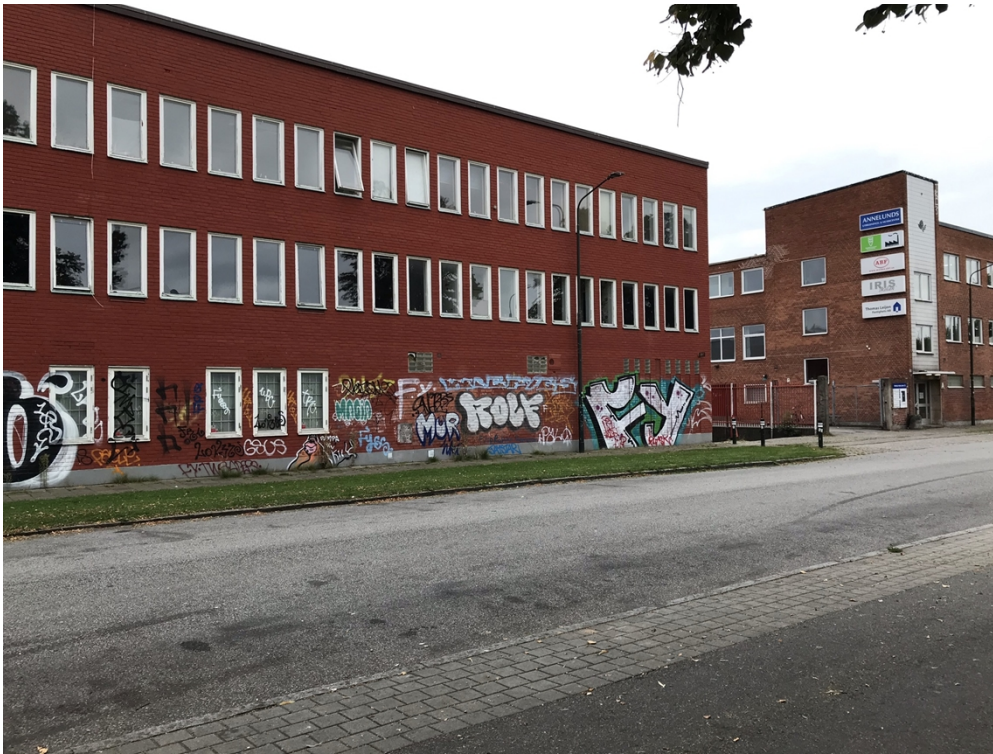
Den högre byggnadskroppen i planområdets norra del är synlig till vänster i bild.
