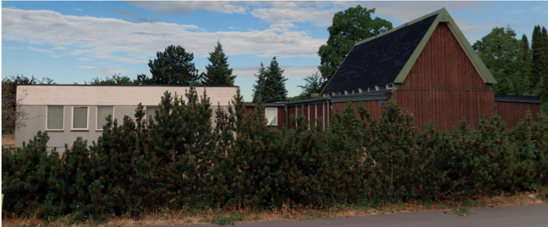
Befintlig kyrkobyggnad sett från Västra Skeränlingevägen.
