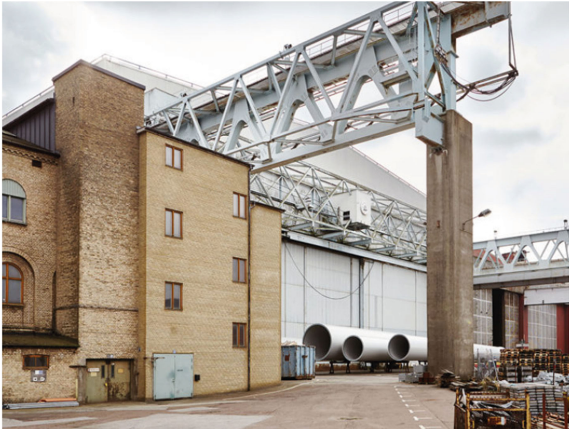
Kranbana som bevaras som en framträdande byggnadsdel från varvstiden. Snickeriet till vänster i bild. Direkt väster om kranbanan möjliggör planförslaget ett nytt bebyggelsekvarter. Foto: Marge arkitekter.
