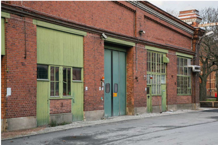
Vagnsverkstaden sett från söder/Jagaregatan. Bildkälla: Marge arkitekter
