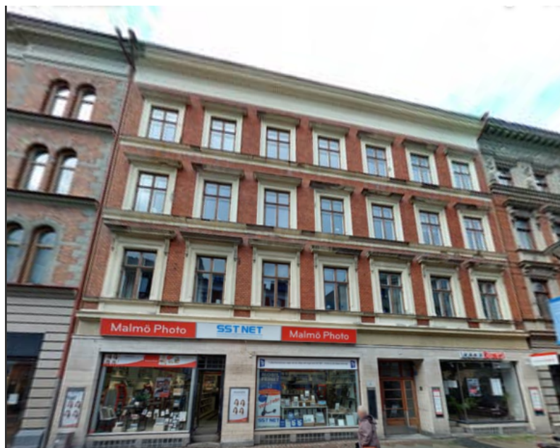
Gatvy över fastigheten Tigern 10 från Södra Förstadsgränd.
