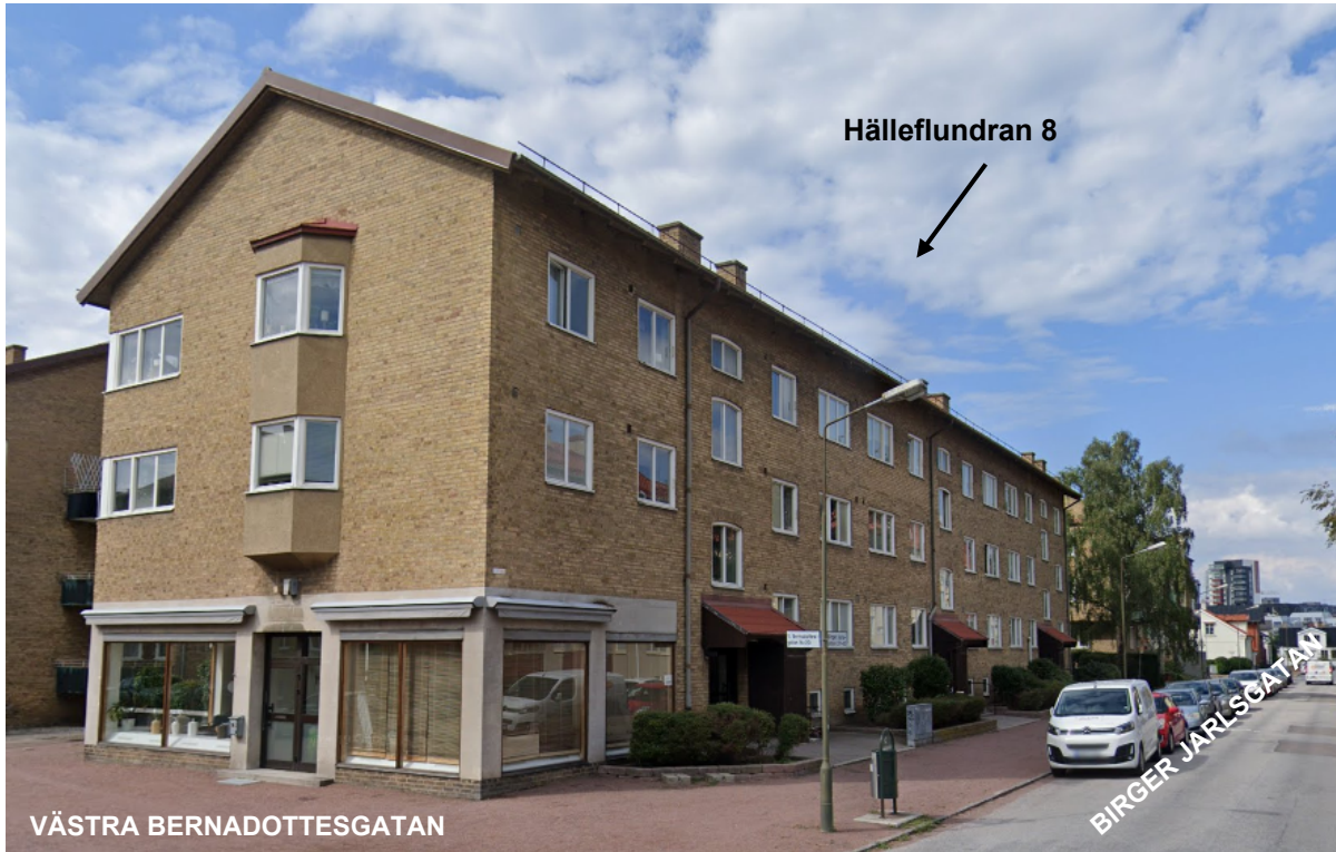
Figur 7. Vy över den östra byggnaden, från sydost.
