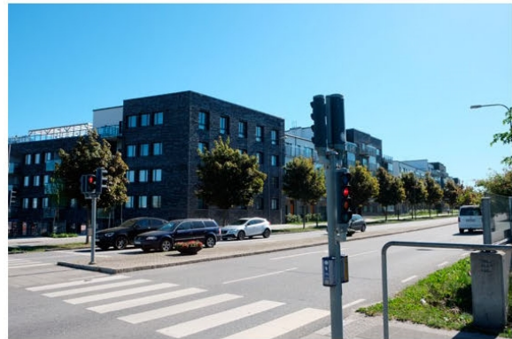
Sallerupsvägen i höjd med Videdal råder liknande förutsättningar som vid Heliotropen. Villor på södra sidan om vägen, och nya flerfamiljshus på norra. Här har man dock valt att stanna vid 4 våningar.
