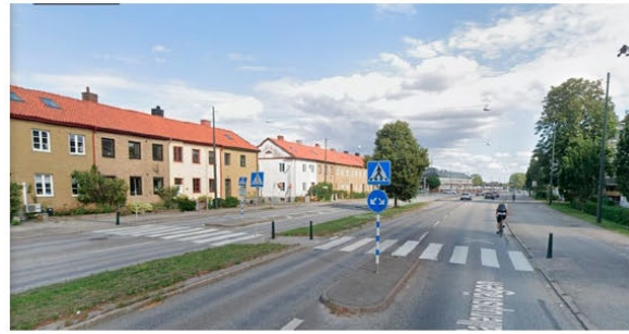
Sallerupsvägen från väster, där Håkanstorp/Johanneslust börjar: 2-våningsradhus.
