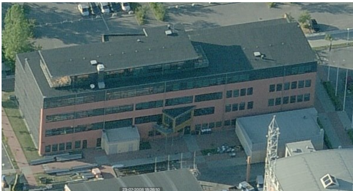
Bild på befintlig byggnad på Jungmannen 1.
