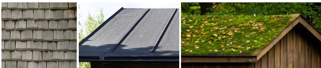
Exempel på takmaterial
