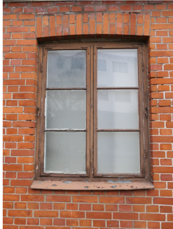
Figur 7. Bilderna visar typ av dörr och fönster på portvaktsbostaden som avses i ny bestämmelse q 2 , det vill säga ursprunglig dörr, med pärlspontspanel och överljus samt ursprungligt fönster, med hörnjärn.
