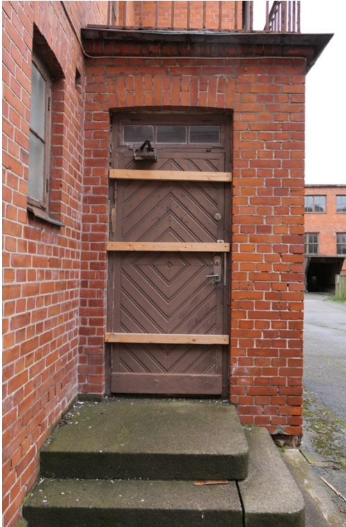
Figur 7. Bilderna visar typ av dörr och fönster på portvaktsbostaden som avses i ny bestämmelse q 2 , det vill säga ursprunglig dörr, med pärlspontspanel och överljus samt ursprungligt fönster, med hörnjärn.
