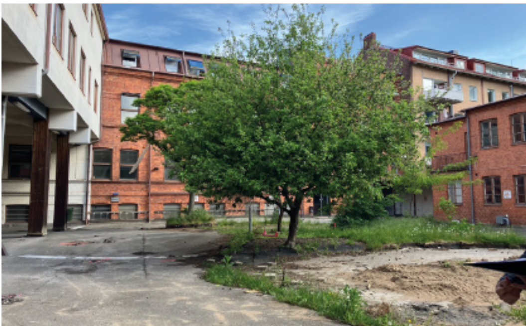
Figur 13. Inngården. Huvudbyggnaden rakt fram i bild är den äldsta byggnaden på fastigheten. Tegelbyggnaden, till höger i bild, är den före detta portvaktsbostaden.
