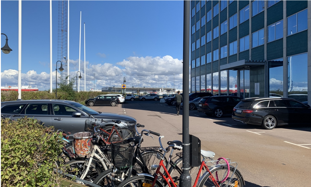
Foto på förgårdsmark till byggnaden Saltimporten inom aktuell fastighet Korallen 1.
