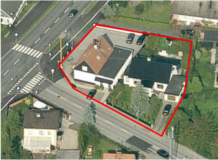
Snedbild över fastigheten sedd mot norr.
