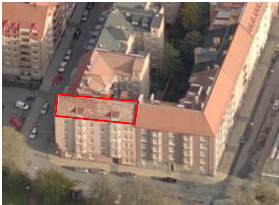
Flygfoto över fastigheten Munken 1, vind markerad med rött.
