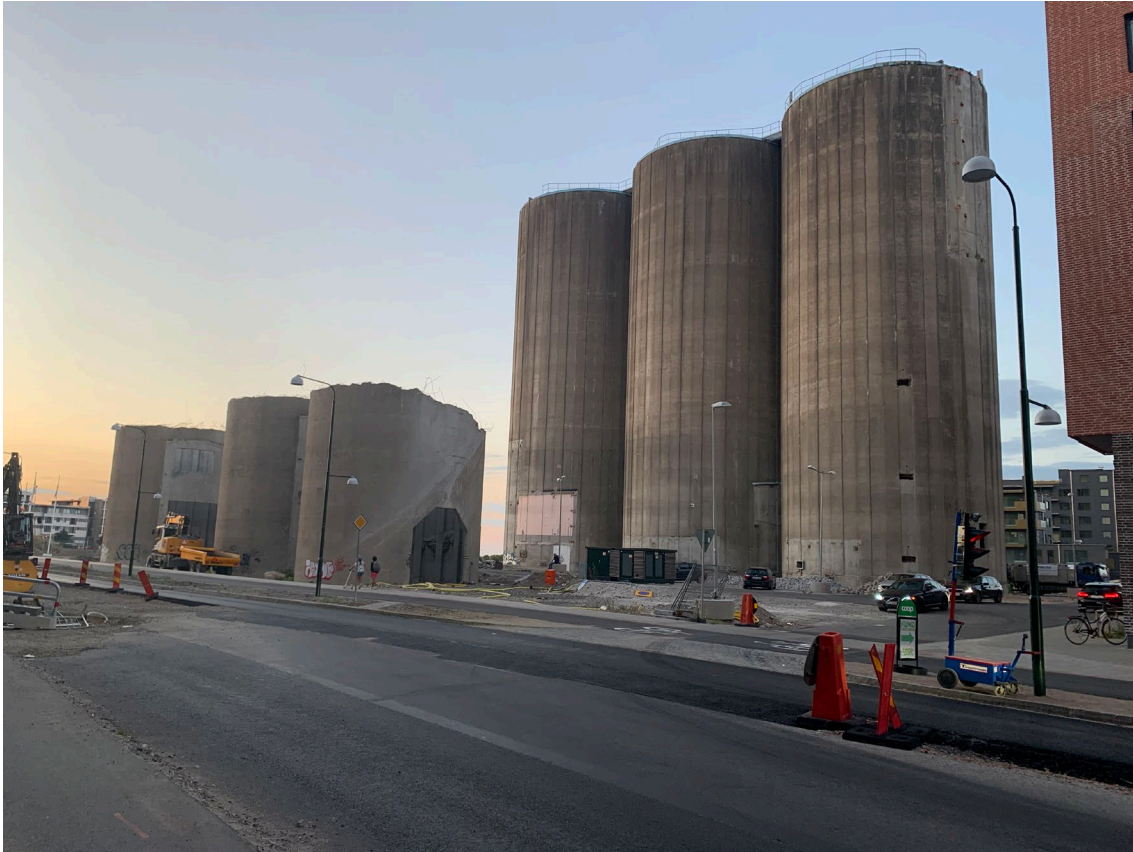
Silorna, år 2020, sedda från Övägen mot nordväst.
