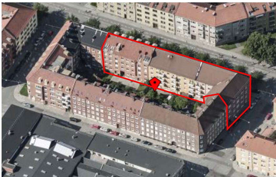
Vy över kvarteret Vakten med aktuell byggnad markerad.
