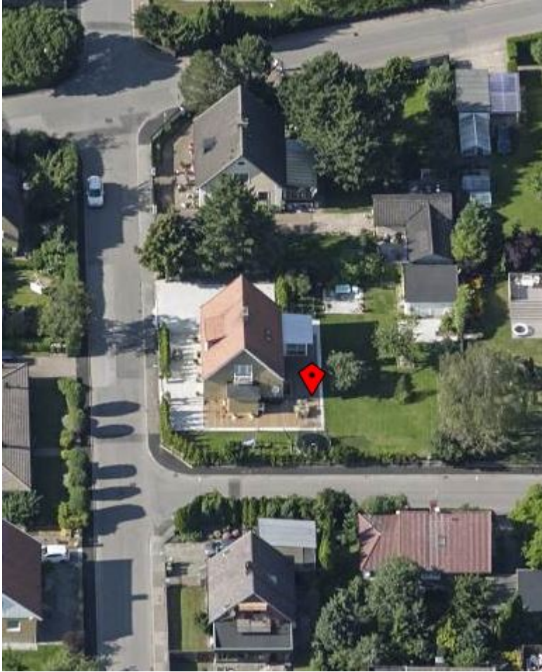
Järtofta 6 sedd söder- och uppifrån
