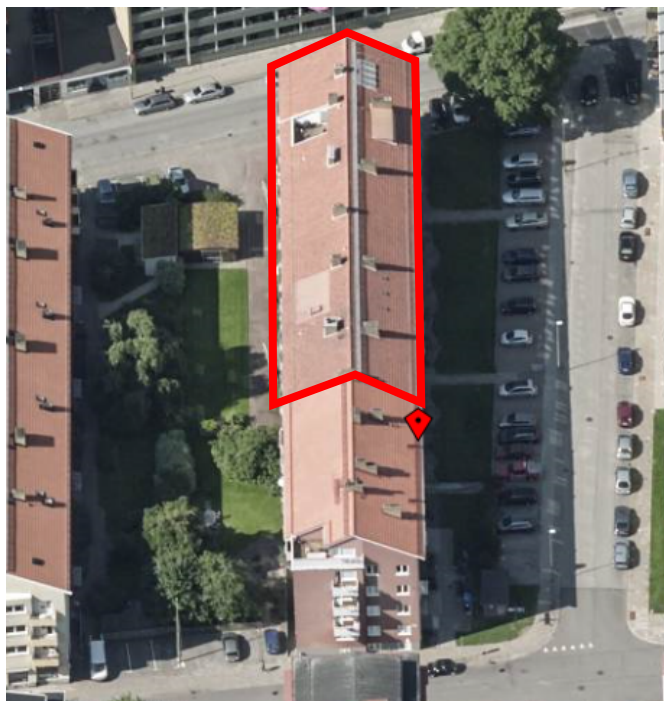
Vy över befintligt hus sett från söder mot norr.
