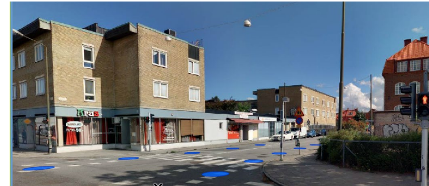
Befintlig gatufasad mot öster/Rolfsgatan
