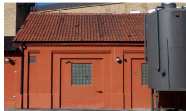
Garage- och magasinsbyggnaden.
