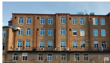
Fabriksbyggnadens fasad mot väster.
