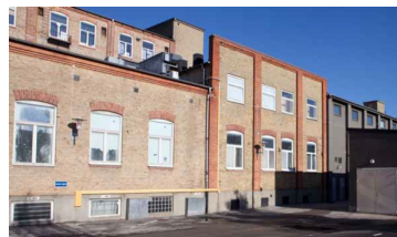
Utbyggnader som byggts på öster om Spinneriet och fabriksbyggnaden.
