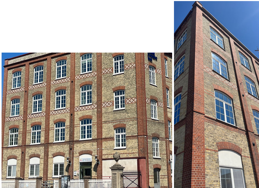
Fasad på Spinneriet, med gesimser, lisener, stickbågar och mönstermurning i rött tegel. Fönster med och utan täckt överlufi.
