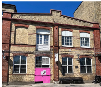
Fasaden på renseri och lager, mot öster, som inte får rivas (q 4 ).
