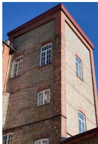
Byggnadsdel med bevarade originalfönster med spröjs.
