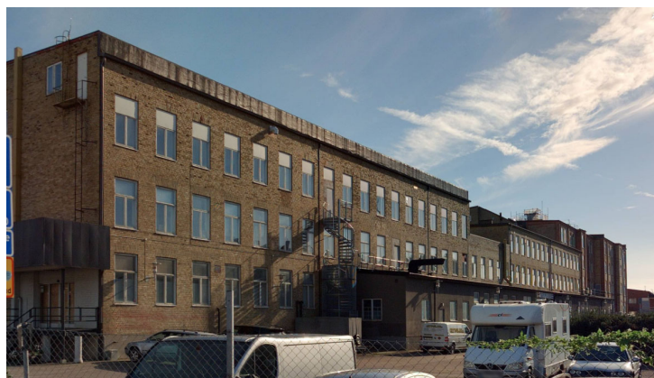
Byggnad 7, vänsalsbyggnadens fasad mot väster.
