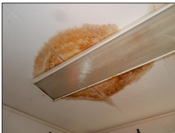
Missfärgning undersida tak
