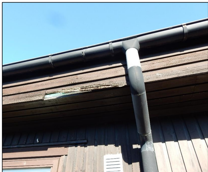
Fuktskadad träpanel
