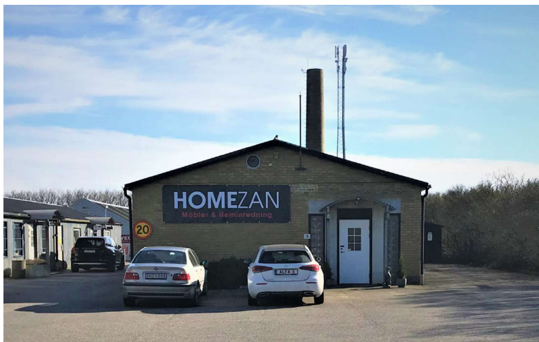
Packhusgaveln hade ursprungligen två portar, nu ombyggt till en enkeldörr med betongglaspartier som sido-ljus.
