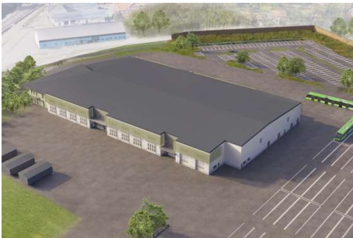
Figur 7 Den tänkta huvudbyggnaden sedd från öster. Notera de utskjutande fasadpartier och den kontrasterande kulörsättning i fasaden mot sydost. Upp till höger i bilden syns bullerskyddsvall krönt med bullerskyddsplank. Innanför bullerskyddsvallen syns personalparkering. Nere till höger syns en del av uppställningsytan för bussar. Illustration: Afry.
