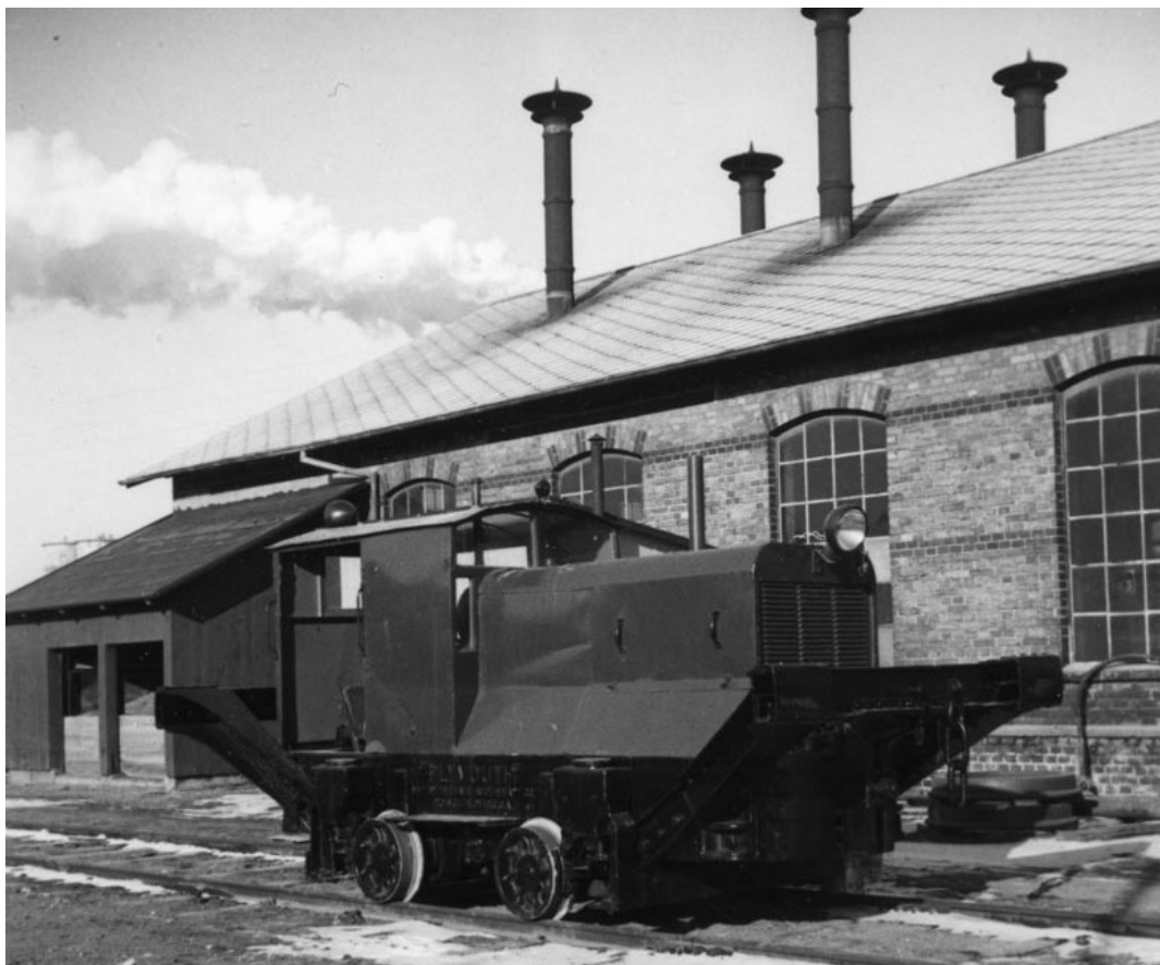
Lokstallet på 1940-50-talet. De gamla ventilationsskorstenarna är kvar, men taket är belagt med eternit. Källa: Limhamns museiförening.
