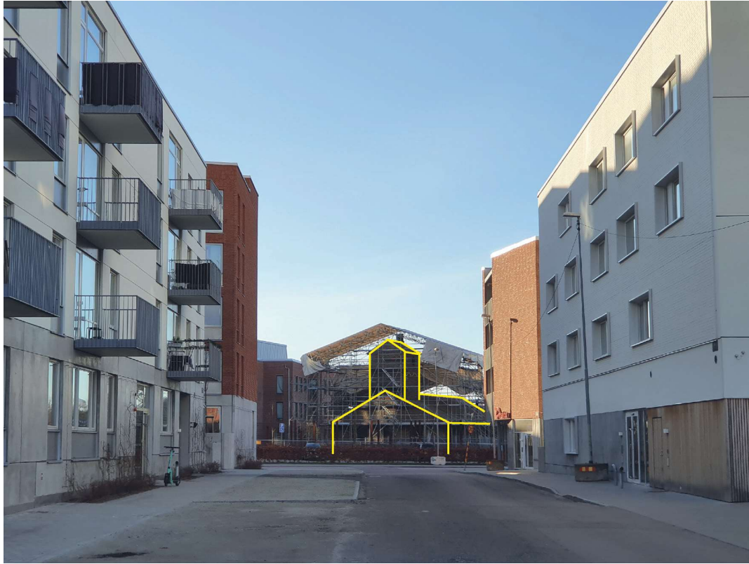
Lokstallet i fonden av Gjutformsgatan. Byggnadens konturer är markerade eftersom den var dold av byggställningar vid fototillfället. December 2021.
