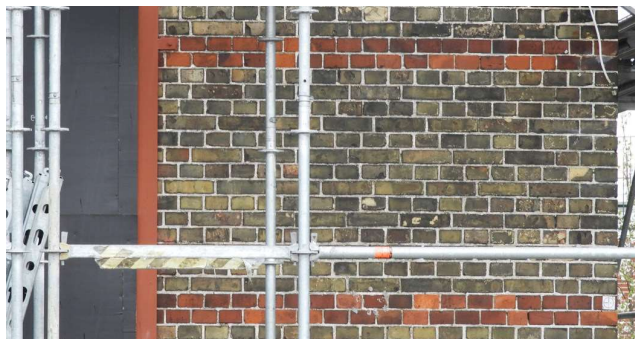
Detalj av fasaden till höger om portarna (fasad mot sydväst), april 2019.
