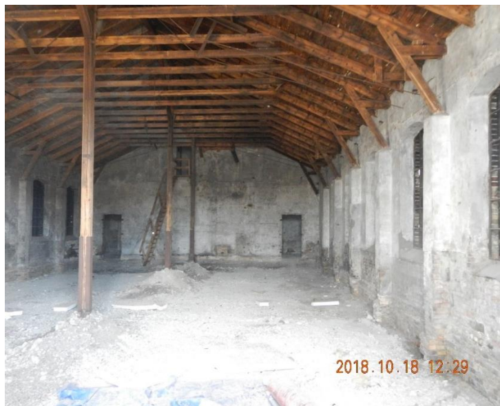
Fasad – Lokstall med vattentorn Interiört – Tegelstomme samt takkonstruktion i trä
