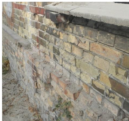
Fasad – Ytterfasad med graffitti och skadat tegel samt porigt tegel från kolsyreblästring
