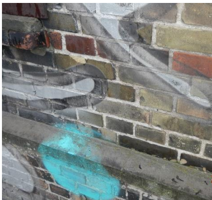
Fasad – Ytterfasad med graffitti och skadat tegel samt porigt tegel från kolsyreblästring
