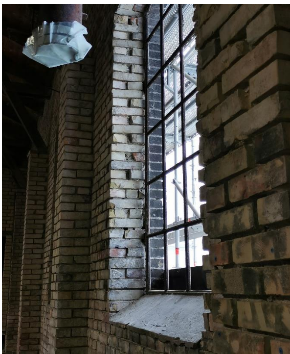
Fasad – 1,5 stensförband
