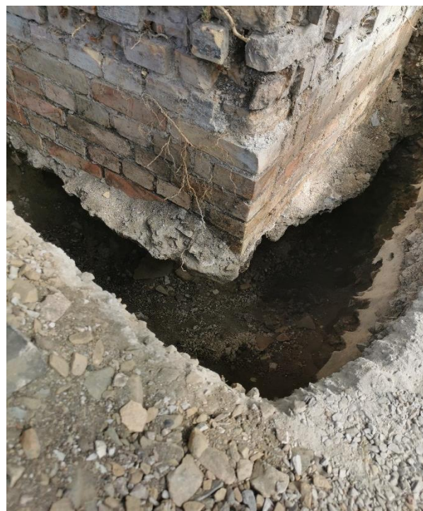
Grundmur – Söndervittrad grundmurskonstruktion
