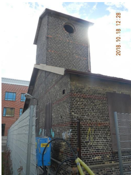
Fasad – Lokstall med vattentorn Interiört – Tegelstomme samt takkonstruktion i trä
