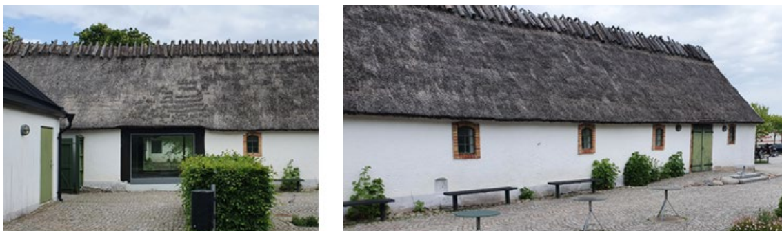
Figur 14. Byggnad D. Till vänster västra delen av södra längans fasad mot söder. Till höger östra delen av södra längans fasad mot söder. (Bild: Olga Schbyter Kulturmiljökonsult, 2022)
