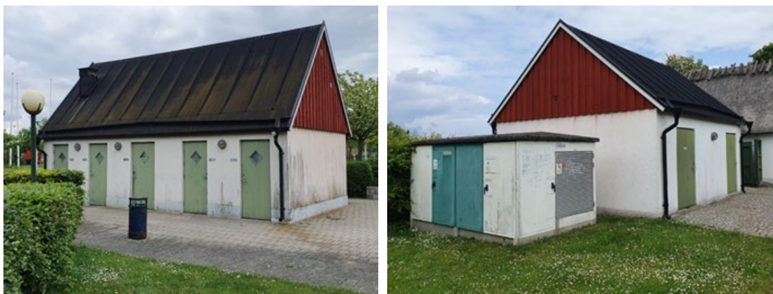
Figur 15. Till vänster byggnad E, toaletthyggnadens fasad mot väster. Till höger byggnad F, miljöhus och förrådsbyggnad. Gavel mot söder och fasad mot öster, med intilliggande transformator. (Bild: Olga Schbyter Kulturmiljökonsult, 2022)
