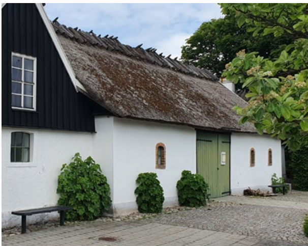
Figur 13. Byggnad C, östra längans fasad mot öster. Till vänster i bild ses del av södra längans gavel (Bild: Olga Schbyter Kulturmiljökonsult, 2022)
