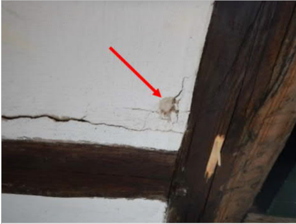
Tidigare prov uttaget på invändig puts
