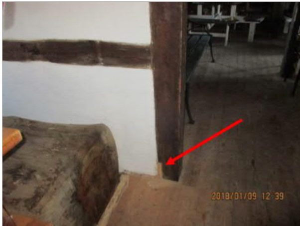
Tidigare prov uttaget på bärande trämaterial
