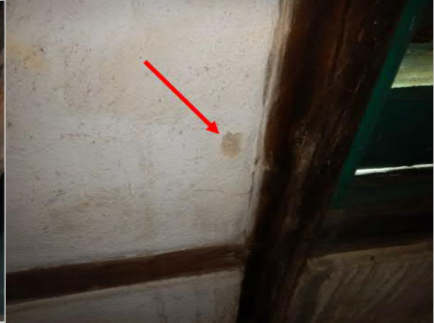
Tidigare prov uttaget på invändig puts
