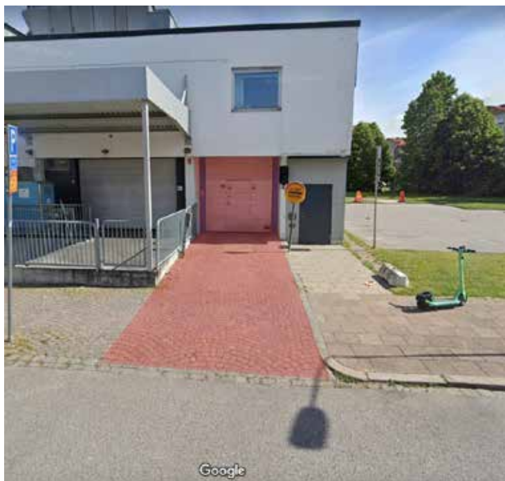
Bild ovan visar utfart från garageutrymme mot Torupsgatan.
