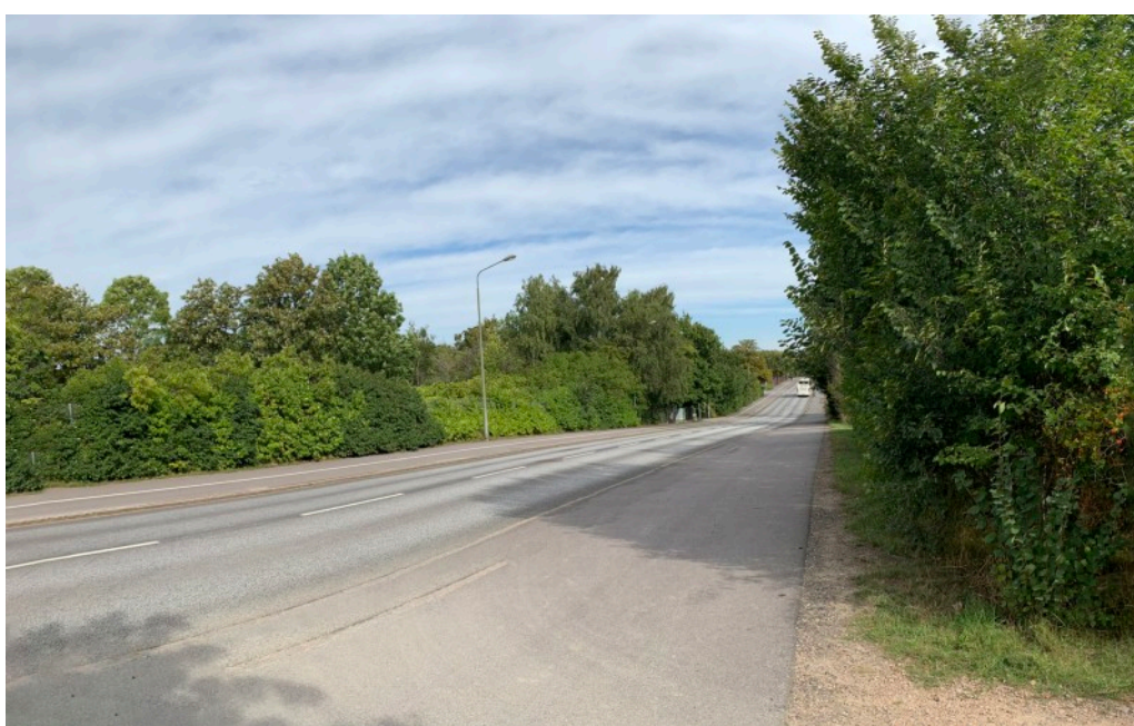
Fotografi, 2022, mot Lv 4-området från Husie Kyrkoväg. Vy mot norr.
