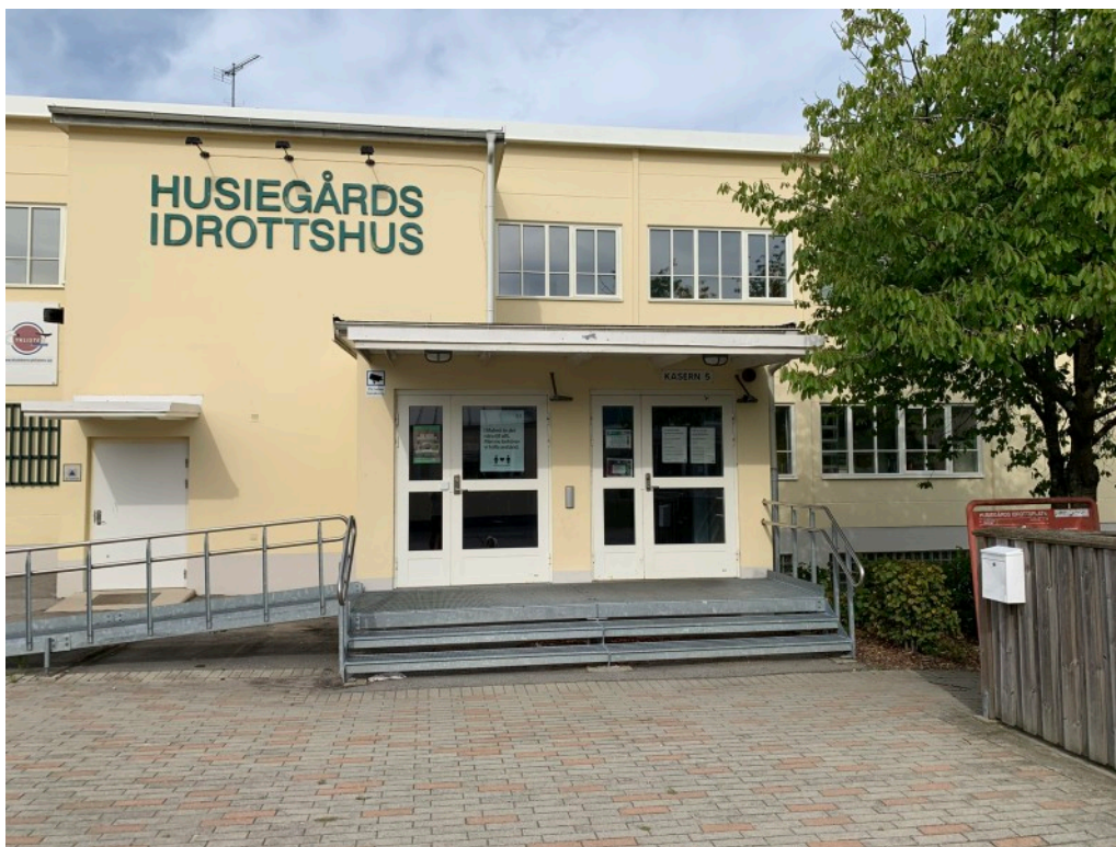
Fotografi, 2022, mot en senare uppförd kasern, som idag inrymmer en sporthall. Vy mot väster.
