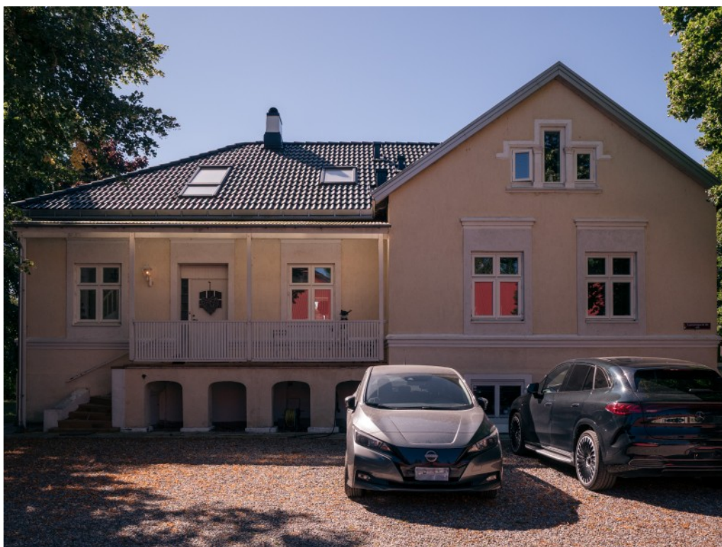
Fotografi som visar mangårdsbyggnaden från gårdsplanen.
