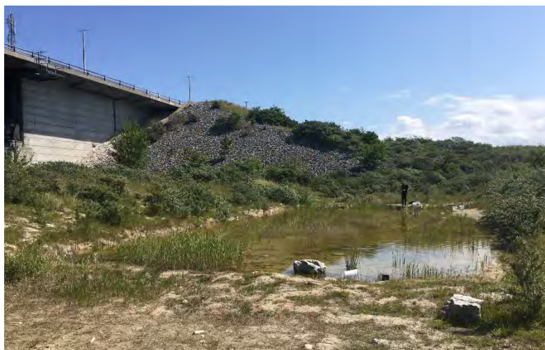
Figur 6. Nygrävd damm år 2006.
