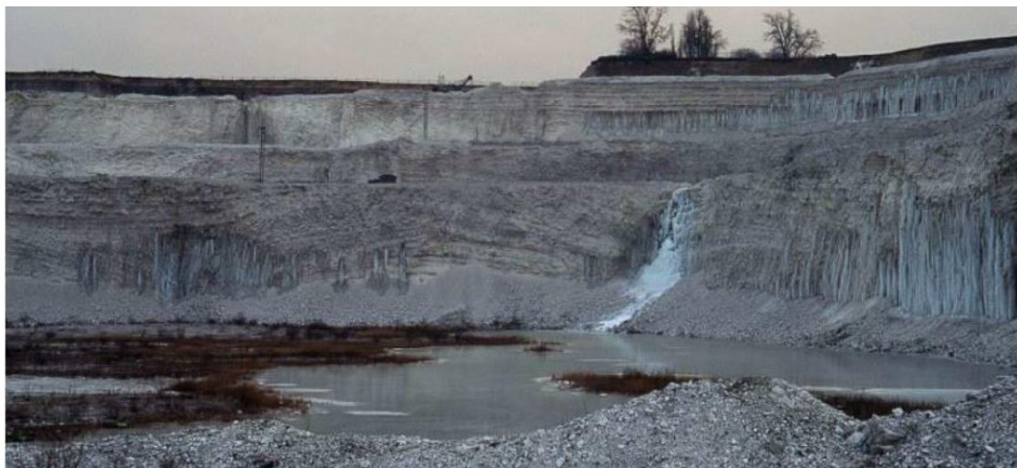
Figur 44. Äldre bild i Limhamns kalkbrott där inflödande grundvatten har frusit till is. I den övre köpenhamnskalkstenen sker grundvatteninflödet från horisontella sprickor medan det styrs av bankstrukturerna i bryozokalkstenen. Bild från Ingenjörsgelogisk kartering (COWI, 2021).
