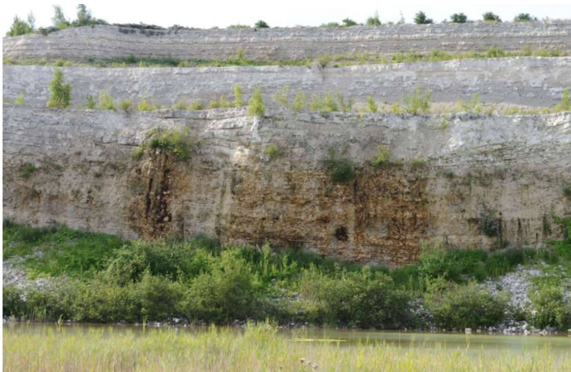
Figur 45. Bryozokalk i den nedre pallnivån. De bruna ockrautfällningarna bildas av grundvattenutflöde genom strukturella sprickor i kalkstenen (COWI, 2021)
