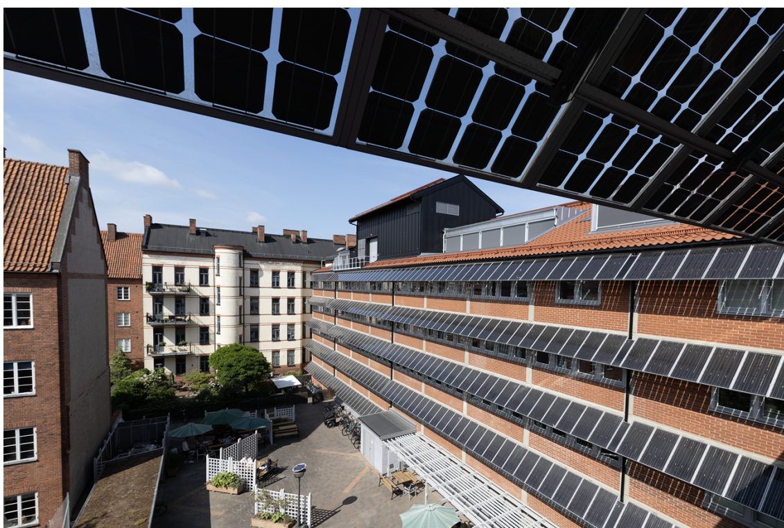
Figur 1. Solceller på en av Malmö stads kontorsbyggnader i Malmö.
