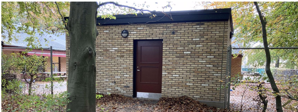
Figur 5. Ny byggnad med toalett för uteförskolan i Pildammsparken byggd av återbrukat tegel.
