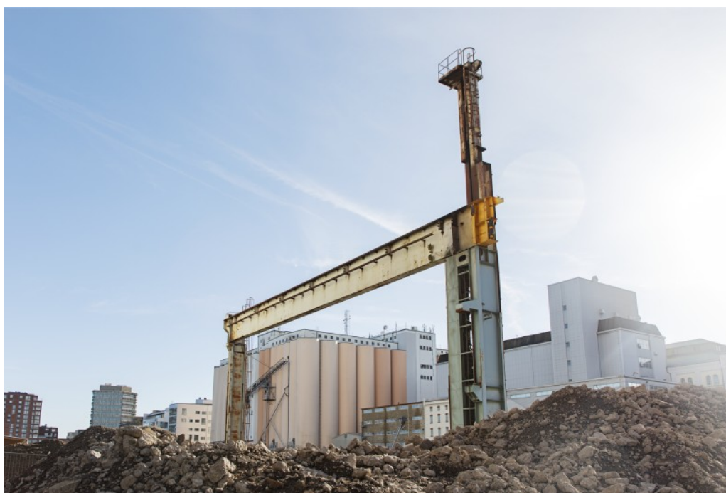
Figur 4. Vy som visar traversen som finns på platsen idag. Vy mot sydöst. Kajkanten är bakom traversen i bild. Källa: Malmö stad.
