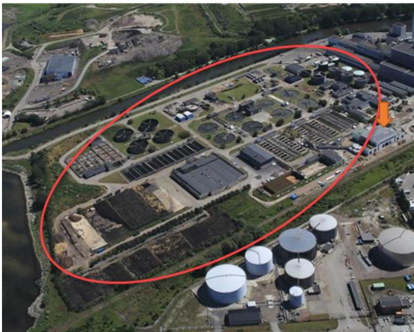
Figur 23. Vy över byggnader inom nuvarande Sjölunda avloppsreningsverk (markerad med röd ring) med kringliggande områden. Inloppsbyggnaden är markerad med en pil.
