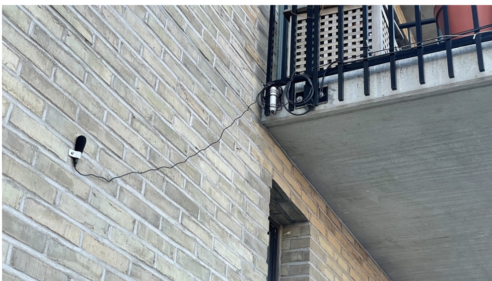
Figur 5. Foto på mikrofon för bullermätning, fasaden vid Nobelvägen 68b.
