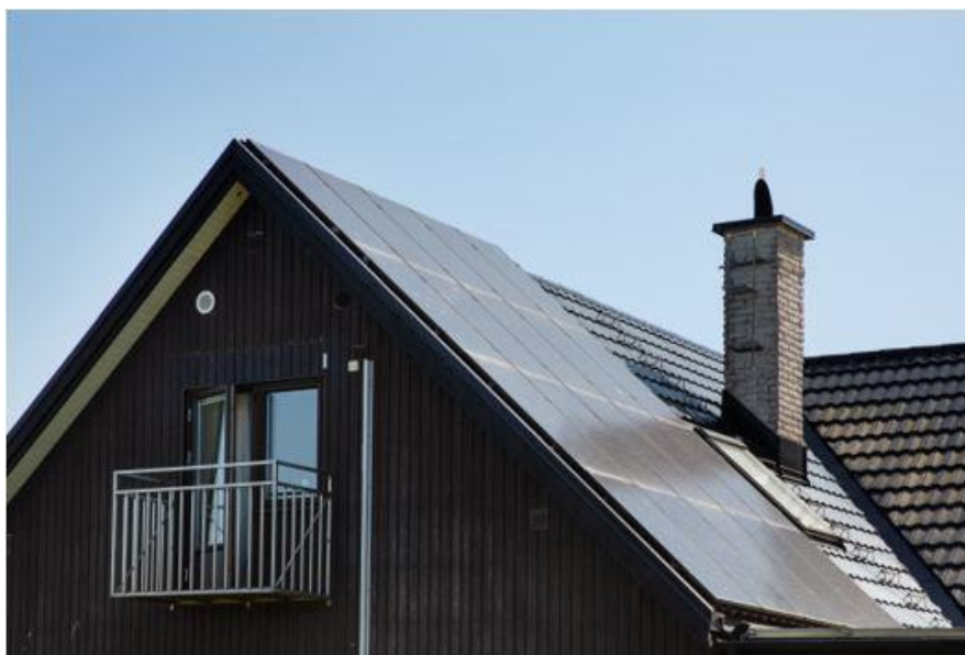
Figur 7. Ett exempel på en solcellsanläggning som passar in bra och till och kan anses ge byggnaden ett intressant arkitektoniskt tillskott. Källa: Solguiden på malmo.se (foto av Bojana Lukac).
