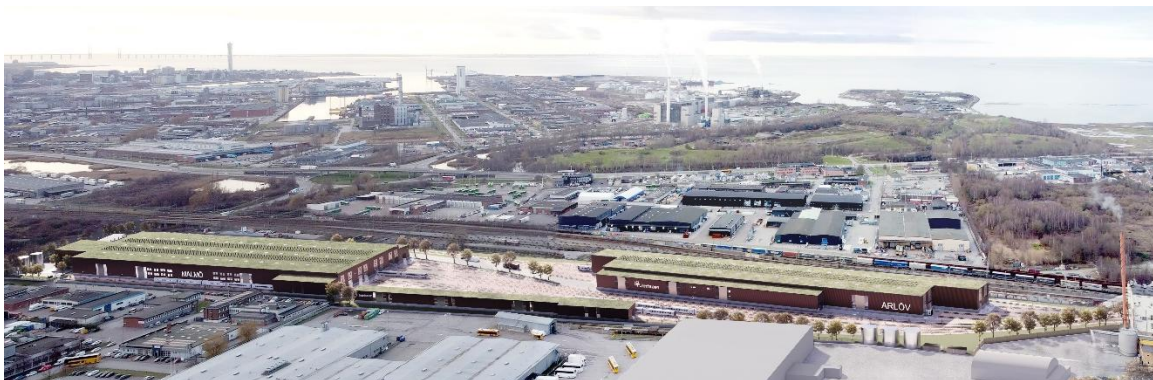
Figur 7. Vy över planområdena österifrån, till vänster i bild Malmöhallen och till höger Arlövshallen.
