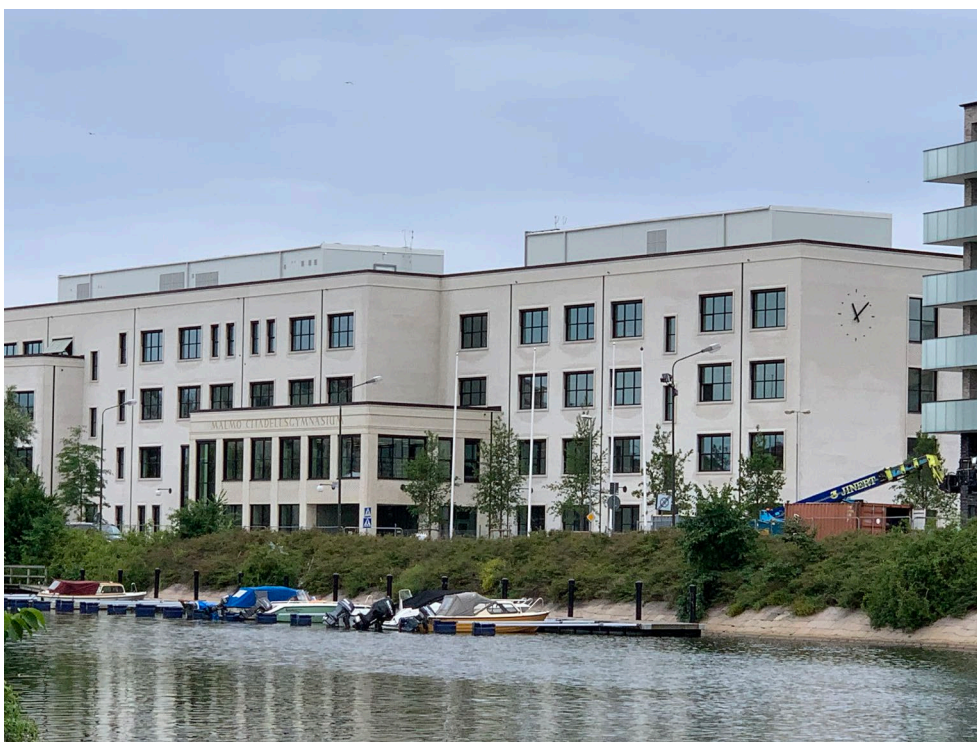
Figur 6. Malmö Citadellsgymnasium vid Citadellskajen. Bild: Malmö stad.
