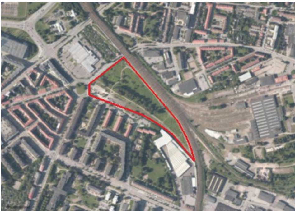
Figur 4. Området i norra delen av Ellstorp i Malmö som bebyggs med tät stadsbebyggelse samt både fördröjningsyta och dagvattenmagasin. Bild: VA SYD.
