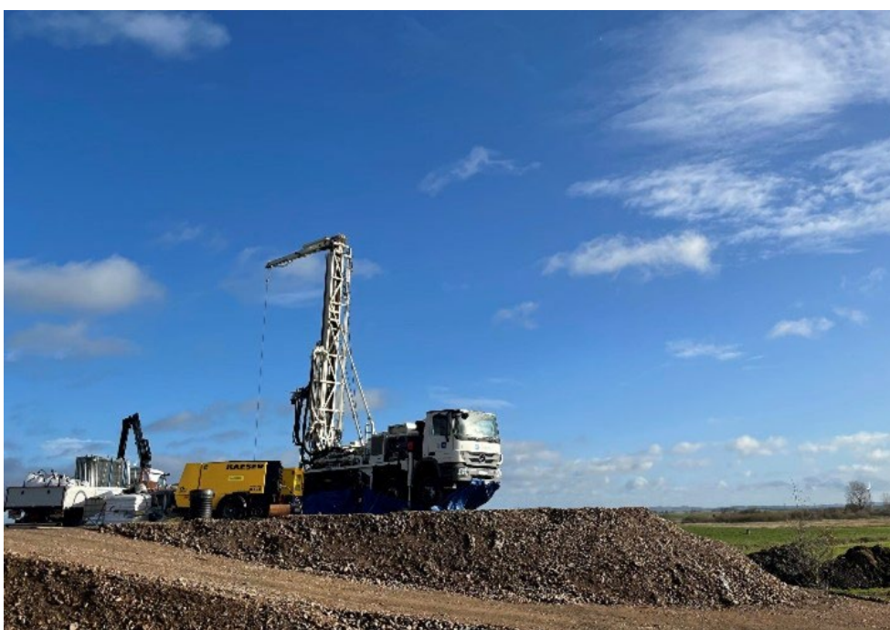
Figur 8. Brunnsborrning vid Grevie vattentäkt. Bild: VA Syd.
