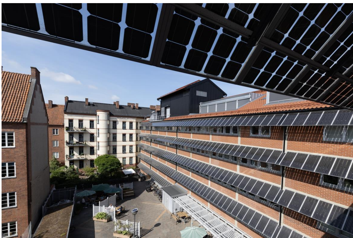
Figur 1. Solceller på en av Malmö stads kontorsbyggnader i Malmö. Foto: Peter Adamsson, Malmö stad.
