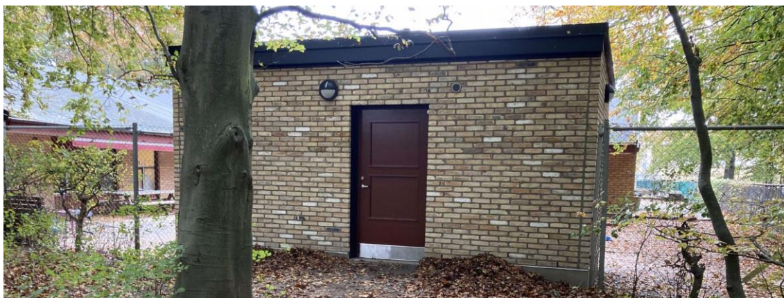
Figur 5. Ny byggnad med toalett för uteförskolan i Pildammsparken byggd av återbrukat tegel. Foto: Hanna Lindahl, Malmö stad.
