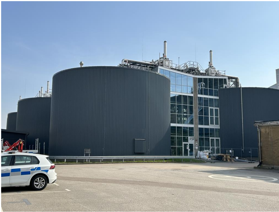
Figur 8. Röt-kammarna på Sjölanda avloppsreningsverk med de nya gasledningarna på toppen av byggnaden. Bild VA SYD.
