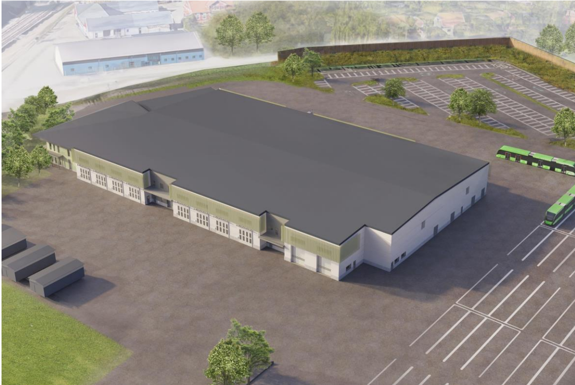
Figur 6 Den tänkta huvudbyggnaden sedd från öster. Notera de utskjutande fasadpartier och den kontrasterande kulörsättning i fasaden mot sydost. Uppre till höger i bilden syns bullerskyddsvall krönt med bullerskyddsplank. Innanför bullerskyddsvallen syns personalparkering. Nere till höger syns en del av uppställningsytan för bussar. Illustration: Afry.
