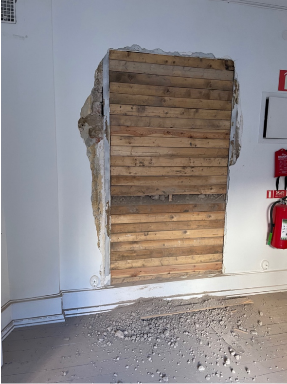
Igensatt öppning mot rum mot gården
