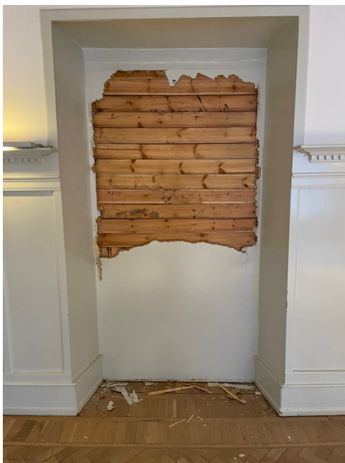
Bef igensatt öppning mot "Börssalen"
