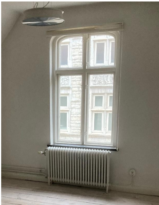
Fönster som enligt förslag 1 planeras att göras om till utrymningsväg.
