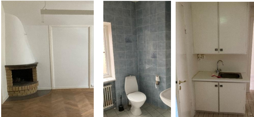
Rum med öppen spis där dörr planeras att öppnas upp igen. Toalett som planeras att förnyas. Pentry med skärmväggar som planeras att avlägsnas.
