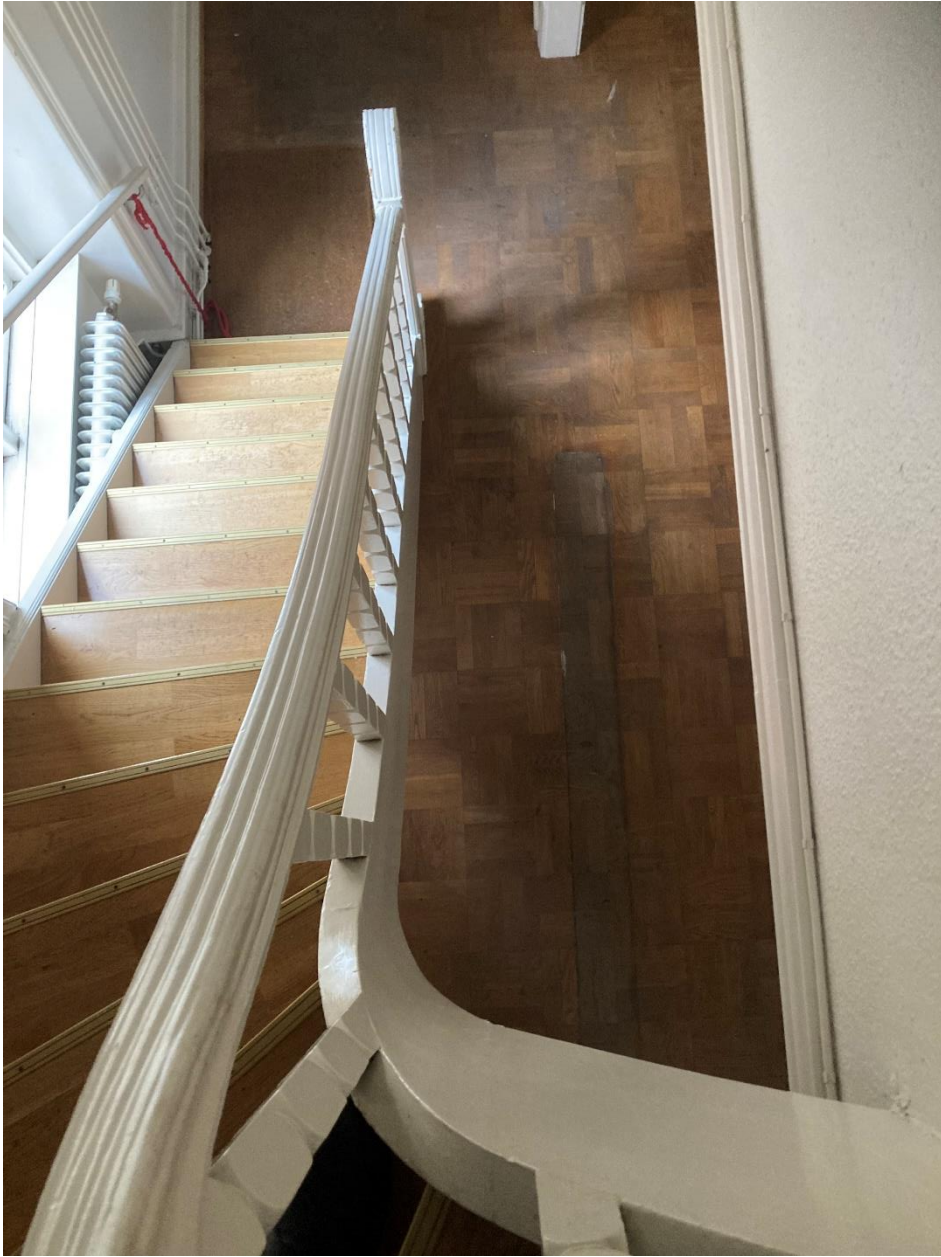
Spår av äldre mellanvägg vid trappan.
