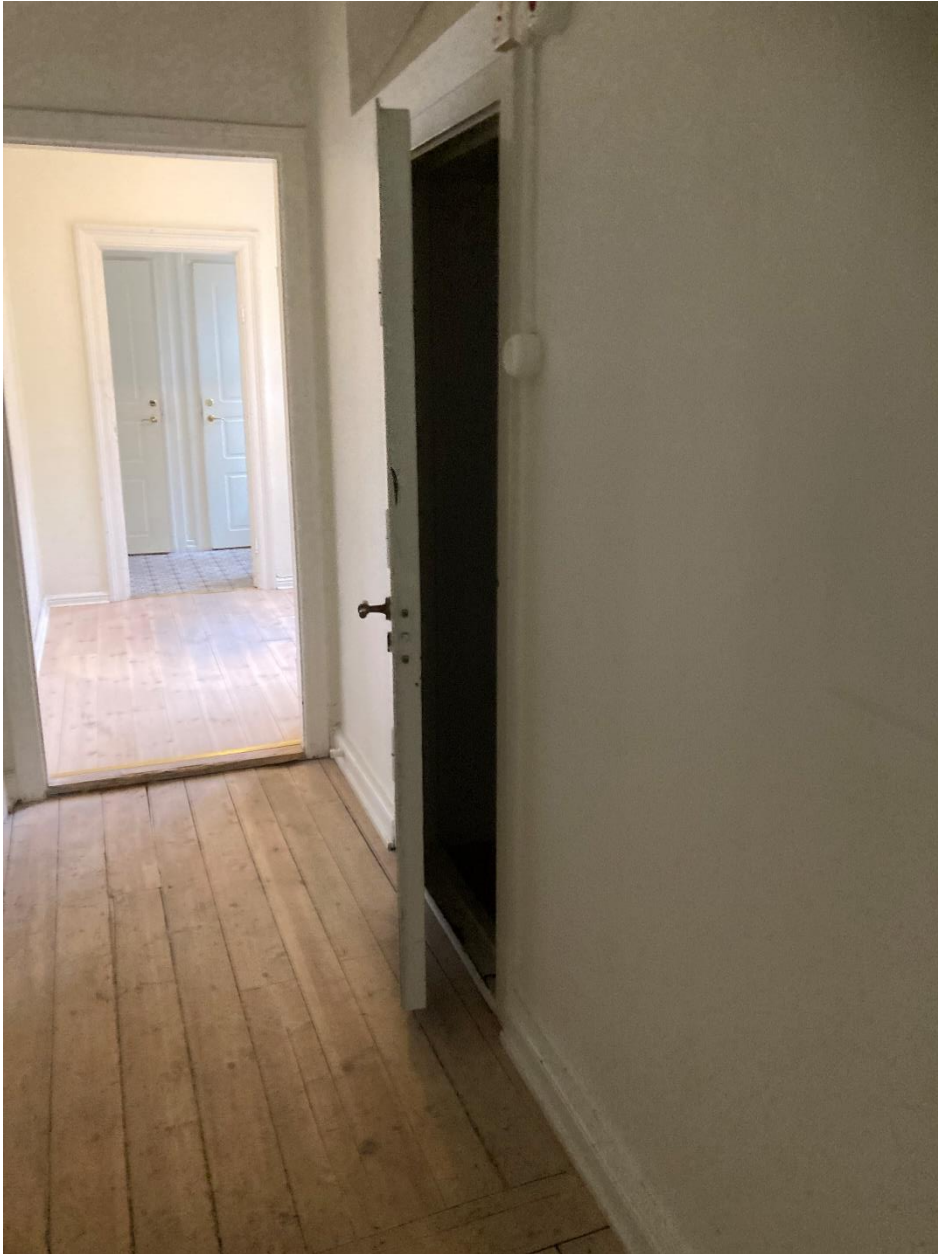
Pansardörr till säkerhetsrummet kommer att tas bort men dörrhålet behålls och förses med ny dörr. Förslagsvis användes de äldre dörrarna på våningsplanet som förebild.
