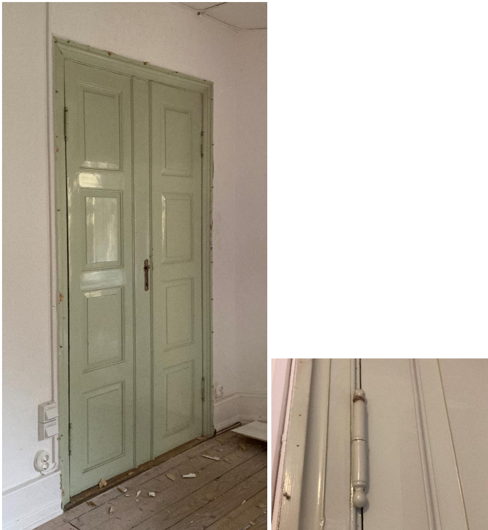
Originaldörr till Börssalen som åter tagits fram och detalj av gångjärn, allt från 1870-talet.
