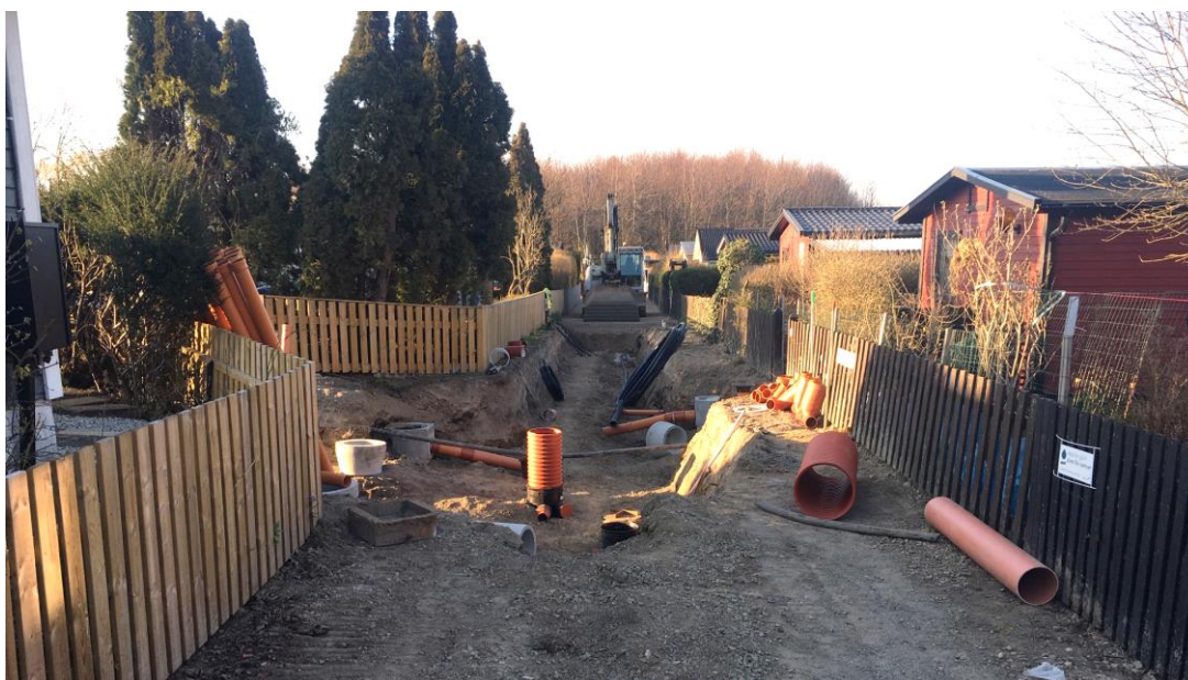
Schaktningsarbete vid anläggning av VA-system i Almåsa Fritidsby. Bild Malmö stad.
