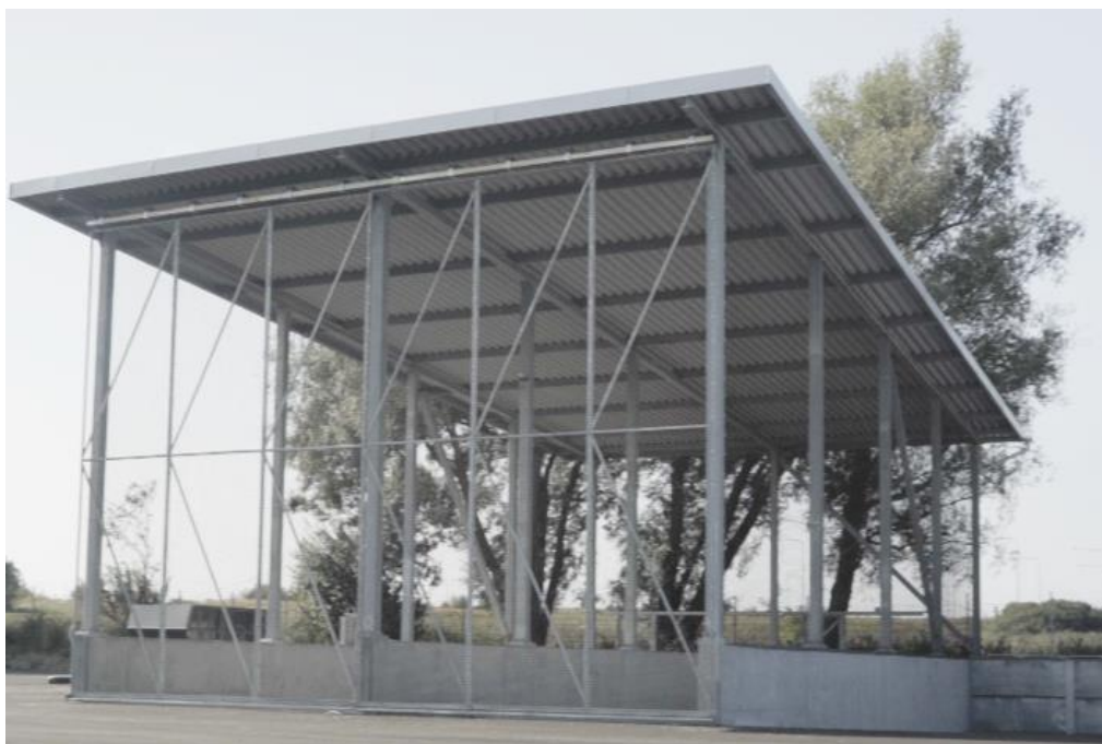
Avvattningsanläggningen i Oxie. Bild VA SYD.
