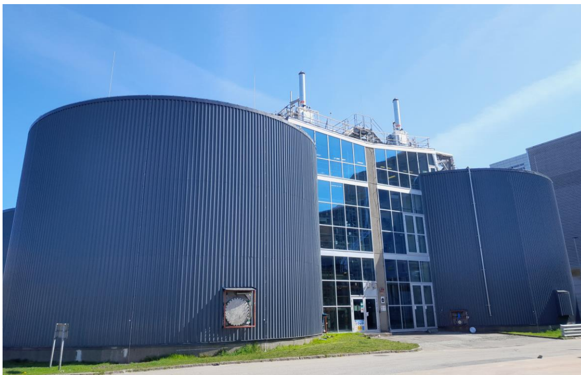
Rötammare på Sjölanda avloppsreningsverk. Bild VA SYD.
