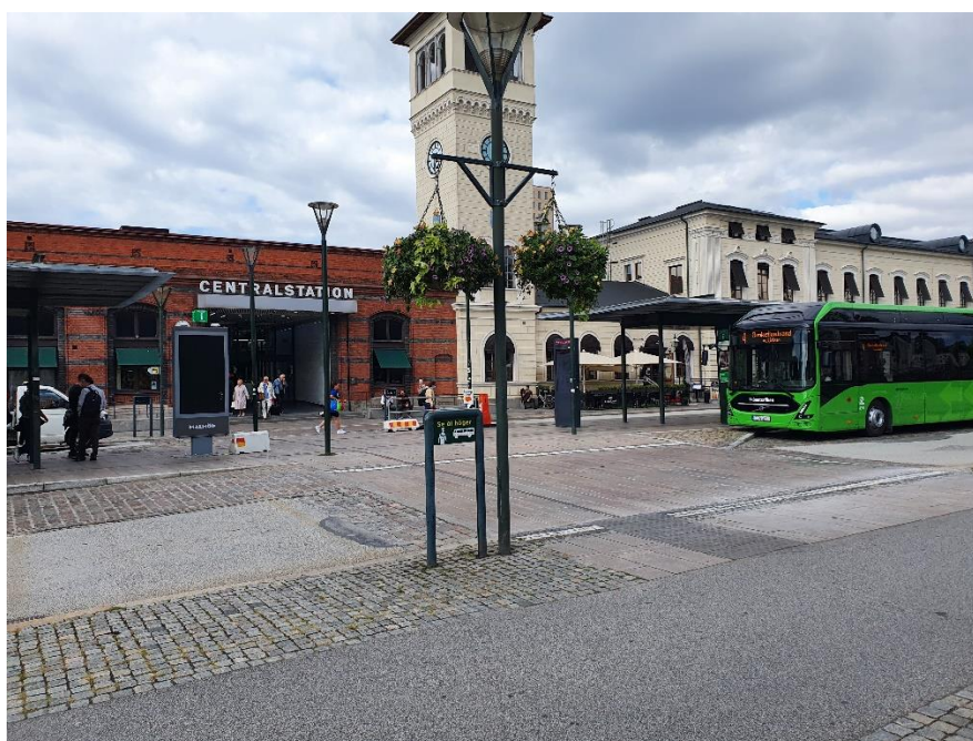
Figur 111. Hastighetssäkrad passage vid centralstationens huvudentré.
