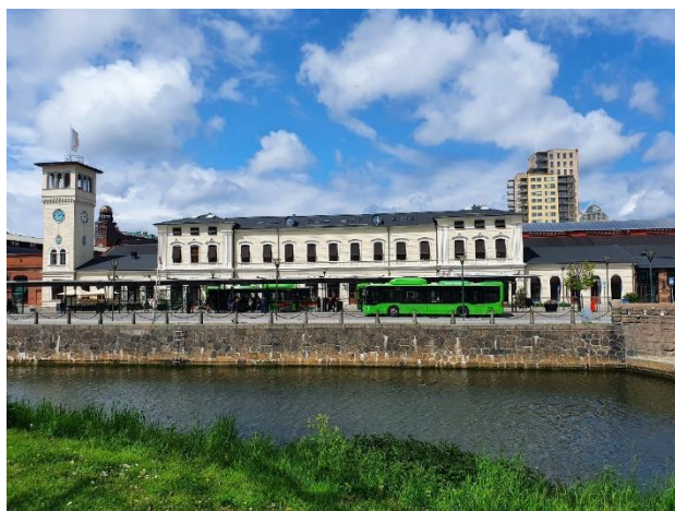
Figur 116. Malmö Centralstation, den äldre delen från 1856.
