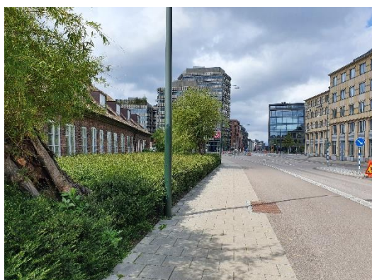
Figur 31. Kyrkans Hus/Sjömansgården till vänster i bild med ett grönskande band av buskar och ett par äldre hamlade pilar
