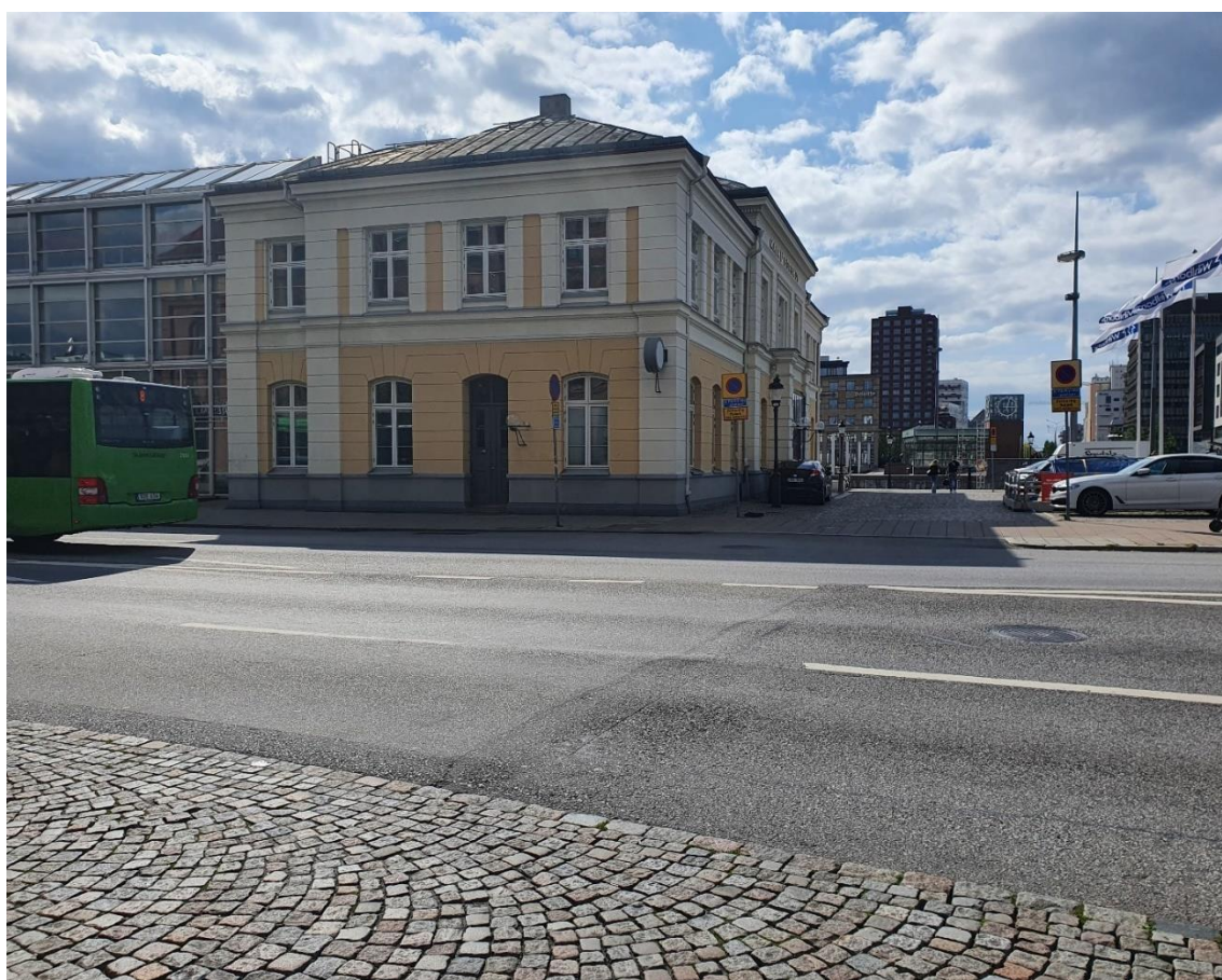
Figur 139. Spårbildning i asfalten på Skeppsbron.
