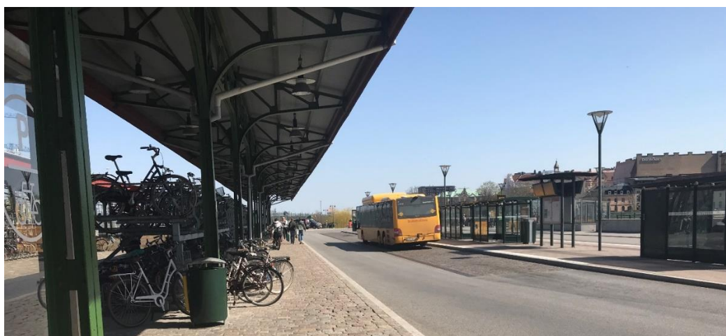
Figur 38. Gångytan på Centralplan nordvästra har en ojämn beläggning med storgatsten samt är smal, särskilt då ytan ofta används för spontan uppställning av cyklar.
