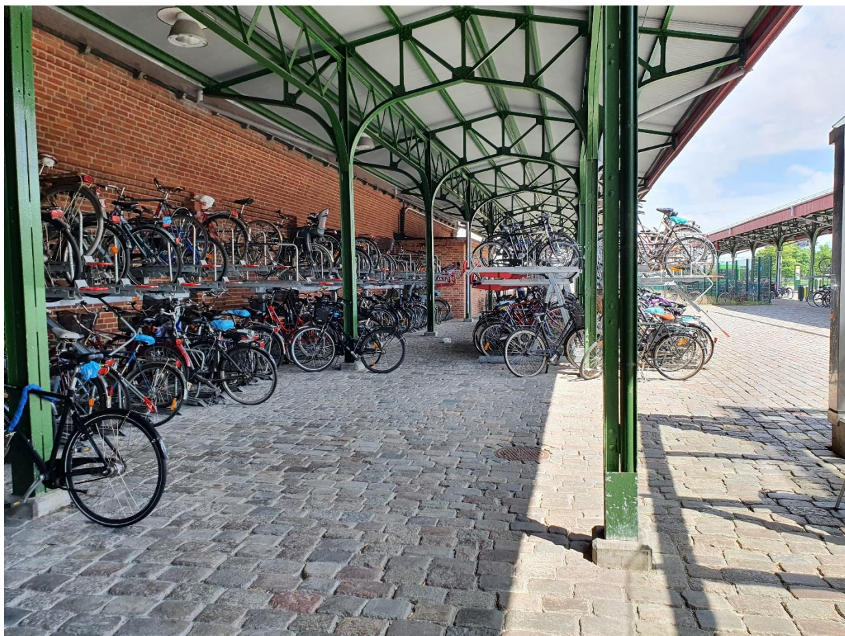
Figur 70. Tråvåningsställ vid östra Centralplan.
