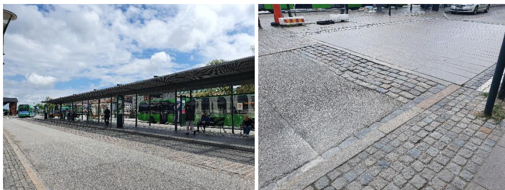
Figur 191. Ojämn beläggning på körbana (t.v.) samt lågt fartbinder på Centralplan (t.h.)
