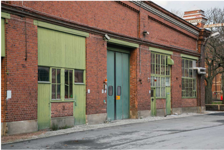
Vagnsverkstaden sett från söder/Jagaregatan. Bildkälla: Marge arkitekter
