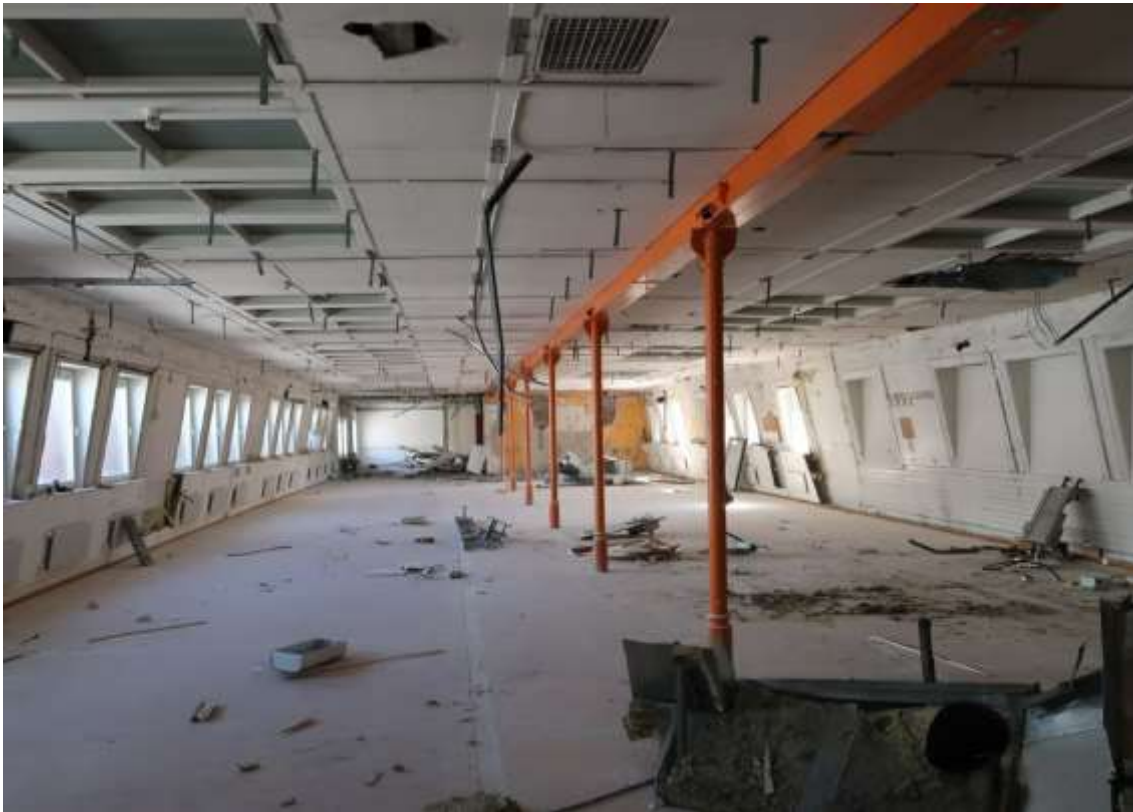
Figur 9. Bilden visar pelarkonstruktionen med gjutjärnskolonner i byggnad mot Västra Rönneholmsvägen, som enligt ny bestämmelse q 4 ska bevaras.
