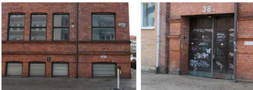
Figur 14. Huvudbyggnad mot Västra Rönneholmsvägen. Fönstren med horisontell indelning sattes in år 1946 och ersatte tidigare spröjsat utförande. Porten är ursprunglig.
