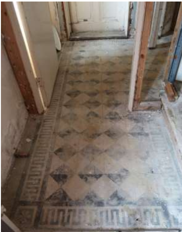
Figur 10. Bilden visar viktoriaplattor i entré mot norr i huvudbyggnad mot Västra Rönneholmsvägen. Bilden visar plattor som avses i bestämmelse k 2 .
