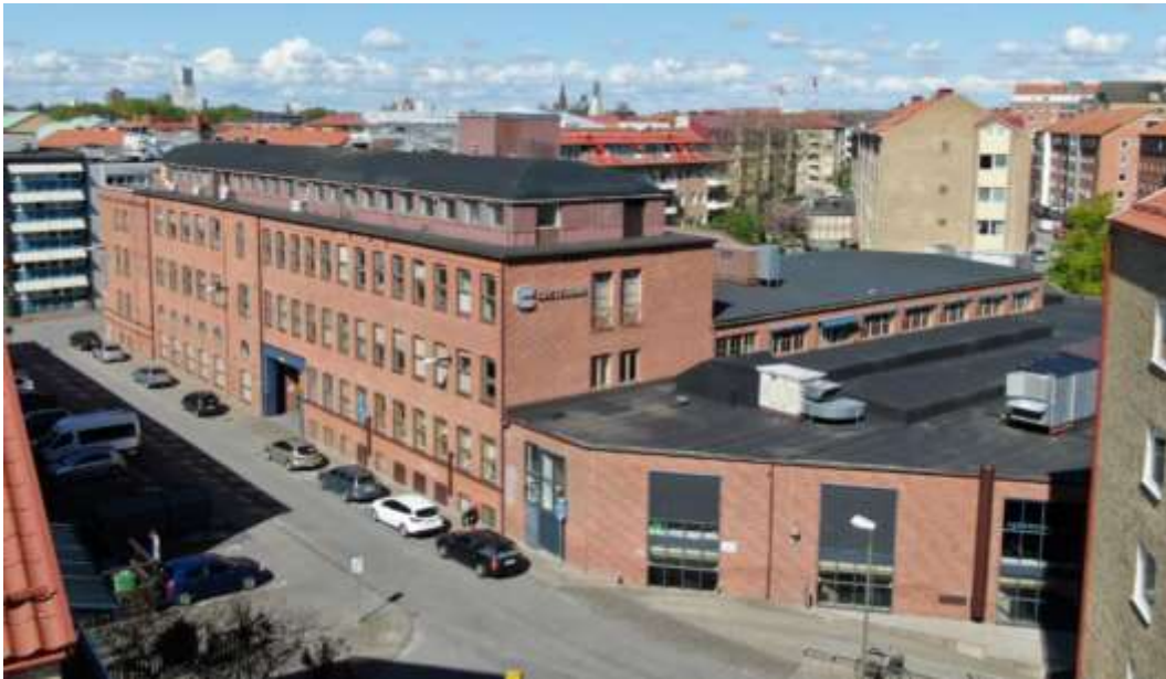
Figur 12. Fastigheten vid Tuborgsgatan. Infart/Ingång till fastigheten sker genom port mitt på byggnaden vid Tuborgsgatan. Infart till underjordiskt garage sker från Tuborgsgatan, vid den lägre byggnadsdelen, till höger i bild.
