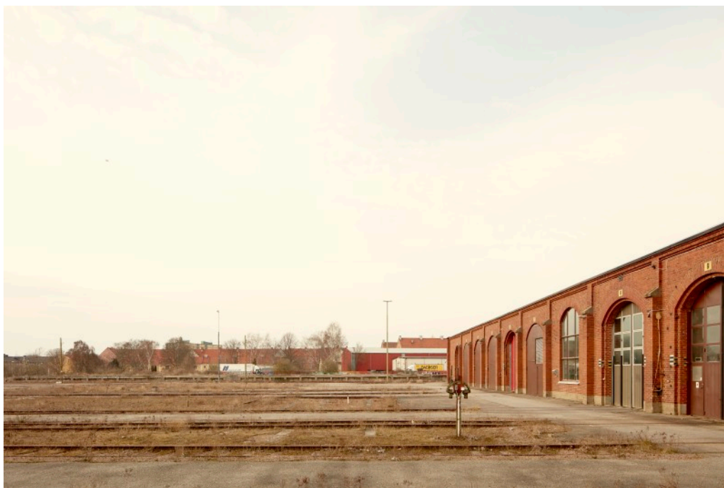
Vy över järnvägsspåren på väg ifrån det stora spårområdet in genom Vagnverkstadens portar. Copyright: Alessandro Guida / paesaggisensibili
