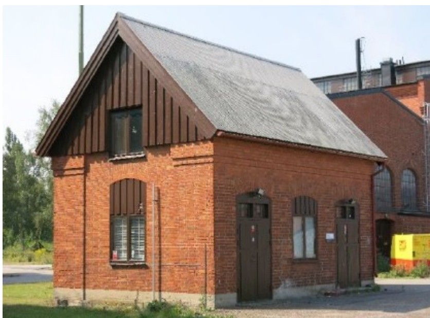
Gasverket, vy från öster, Restaurera.
