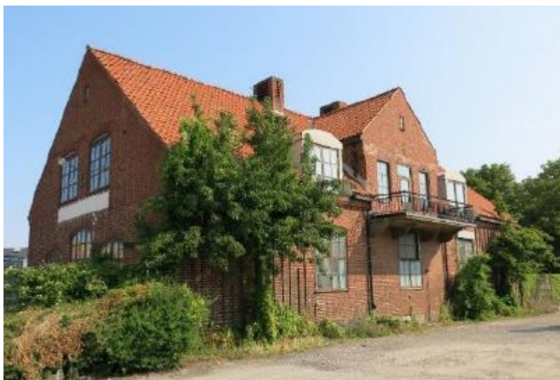
Kontorsbyggnaden, Villan, Restaurera 2014.
