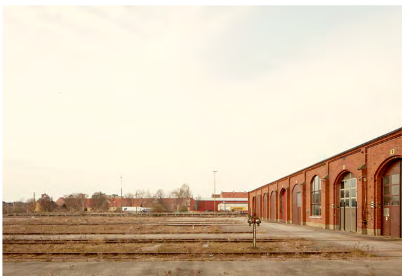
Järnvägsspåren på väg in i Vagnverkstaden. Foto: © Alessandro Guida / paesaggisensibili
