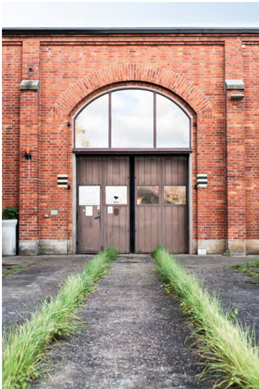
Den befintliga bebyggelsen representerar en omsorgsfullt gestaltad tegelarkitektur med mönstermurningar, valvbågar, strävpelare och detaljer i konststen. Foto: Jernhusen
