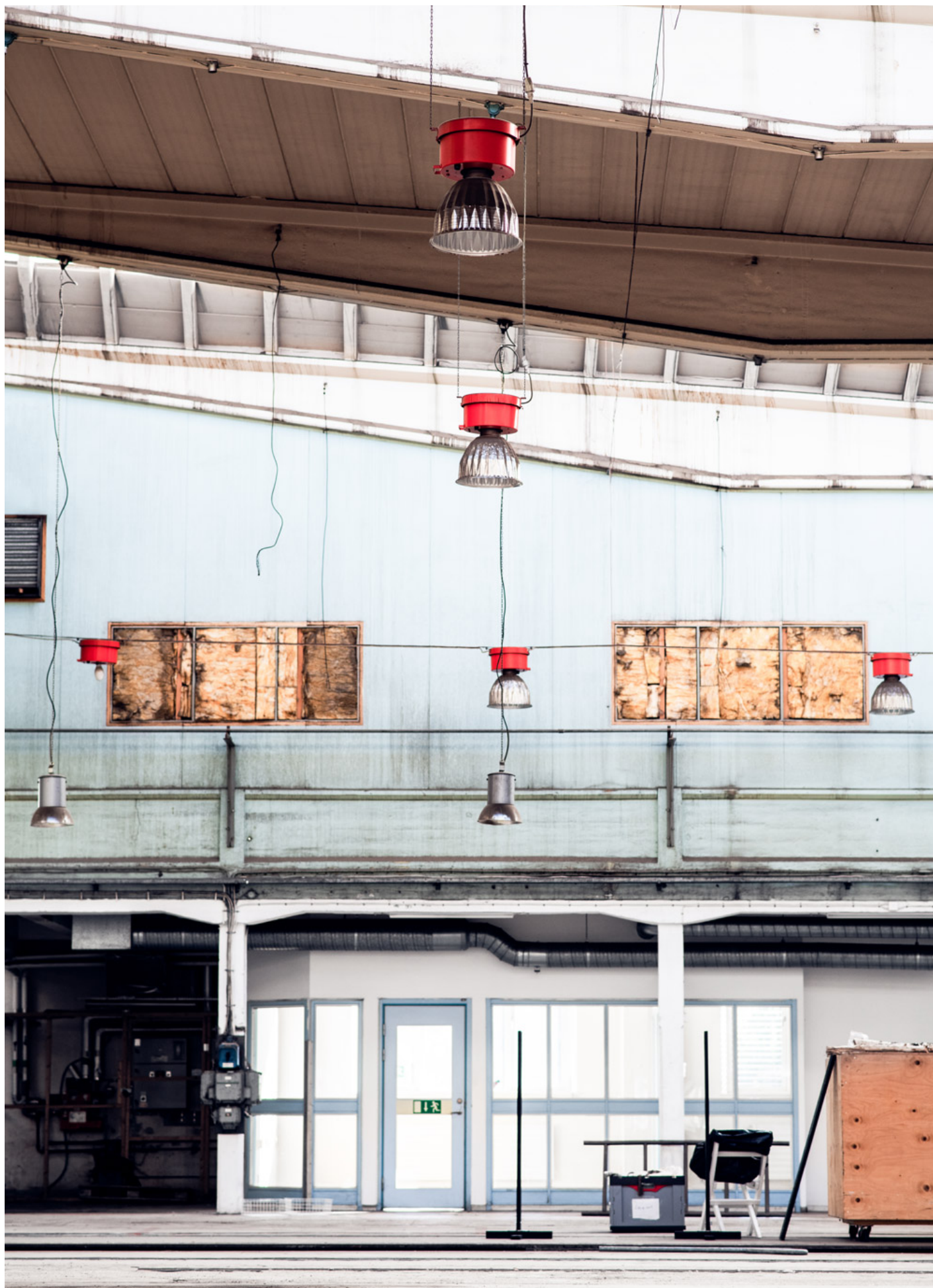
Vagnverkstadens blågröna målade betong och lampor i oranget. Foto: Jernhusen
