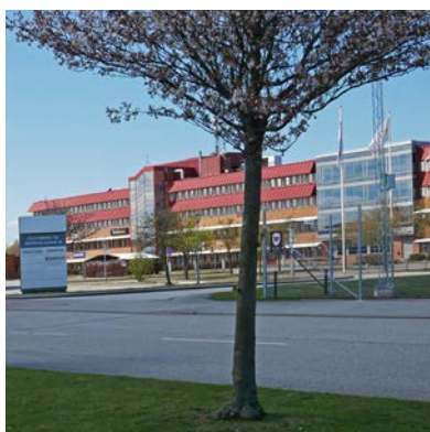
Kontorsbebyggelse vid Jägershillgatan i verksamhetsområdets västra del. Foto: Malmö stadsbyggnadskontor / Tyke Tykesson.
