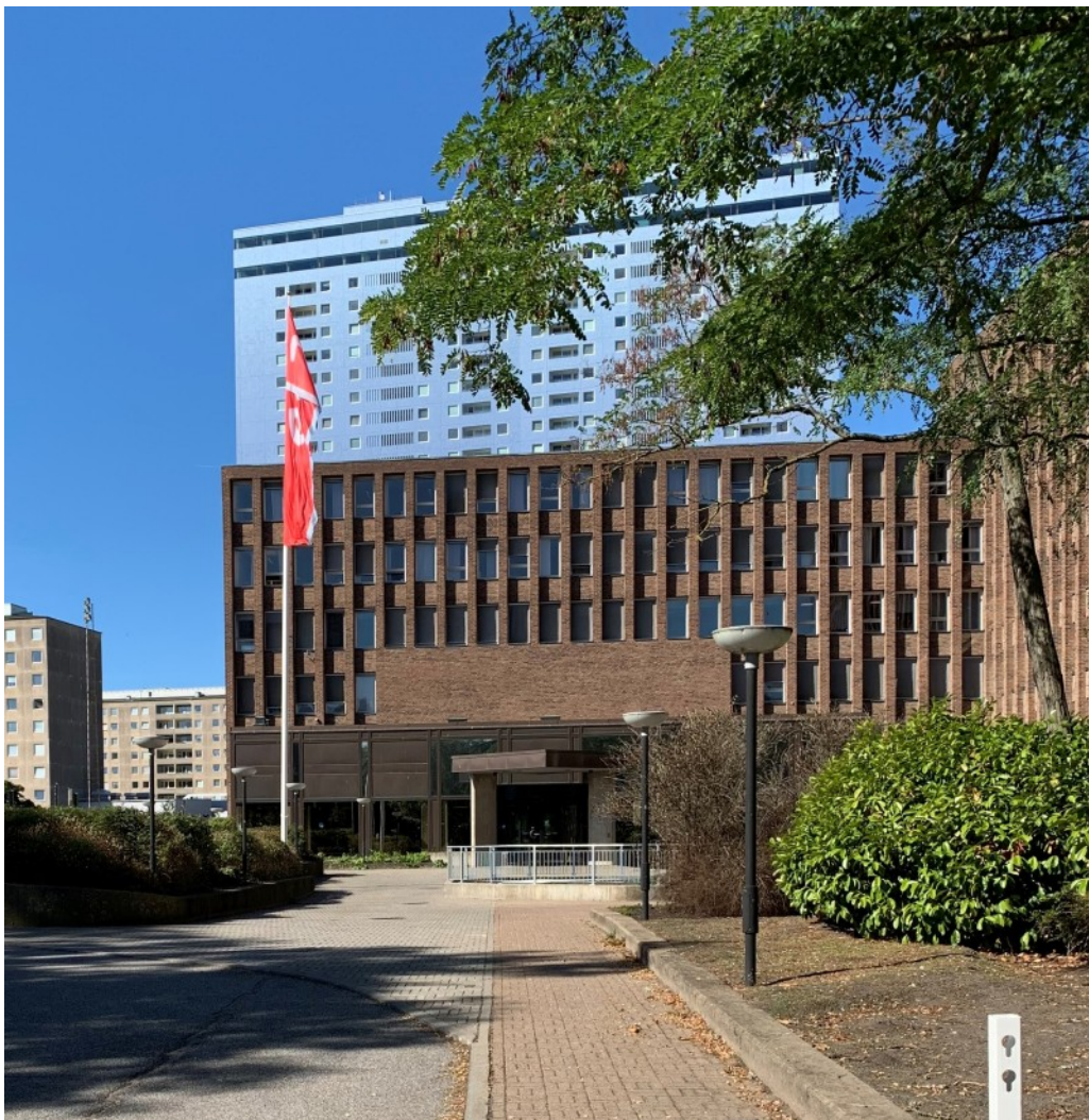
Foto med befintlig entré till byggnad och slutna mursskiva mot öster.
